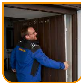
Ausbau und umweltgerechte Entsorgung
